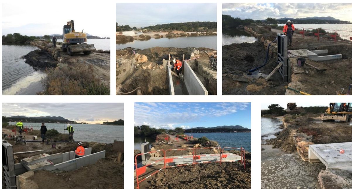
Figure 165 : Phases des travaux d'aménagement du chenal de reconnexion et installation de la martellière – décembre 2019 à janvier 2020.
